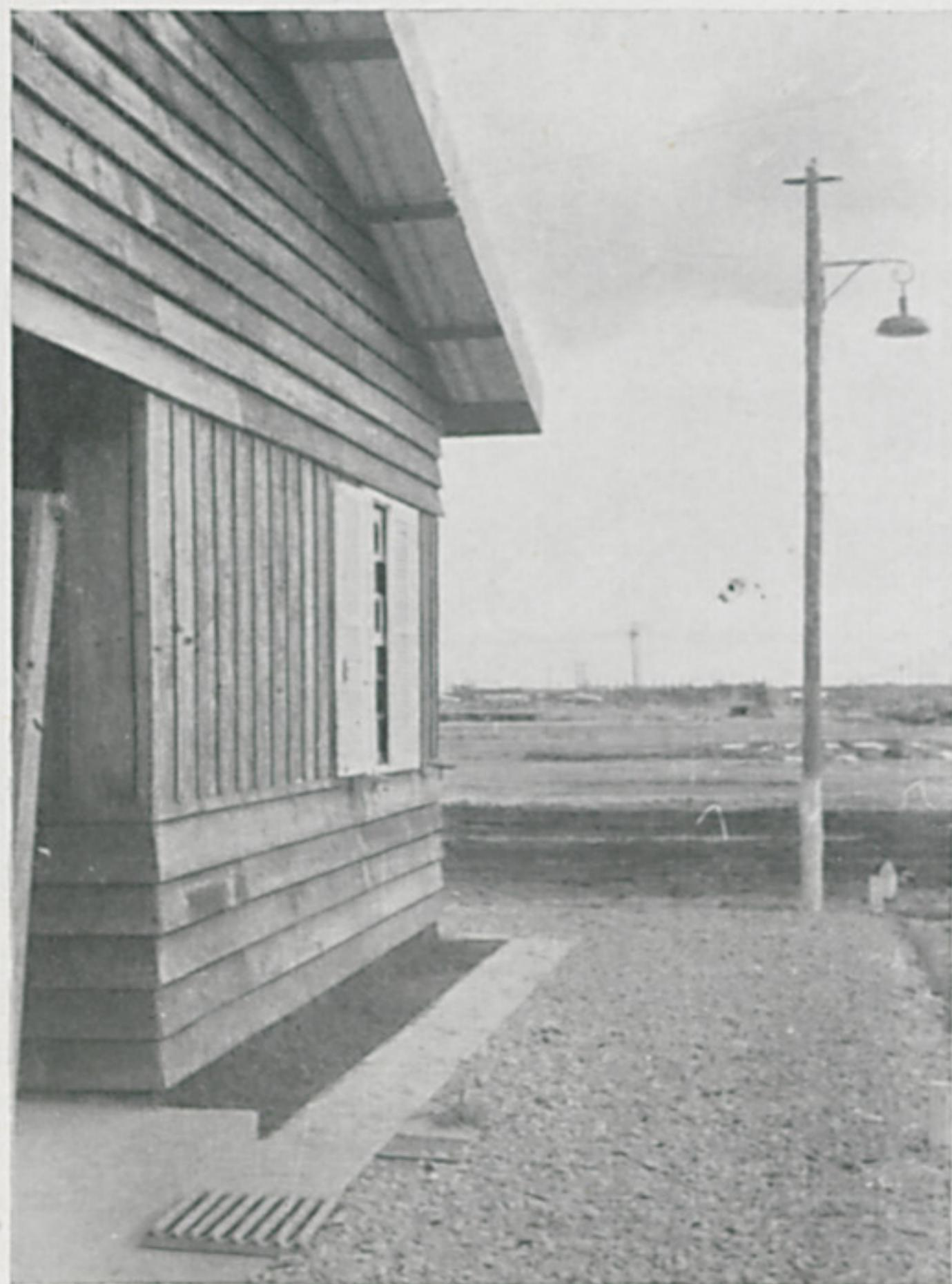
Foto 5: Os bangalôs estavam circundados por uma faixa larga de pedra britada, seguida por estreita faixa cimentada, crescendo grama sob os fundamentos da construção.
