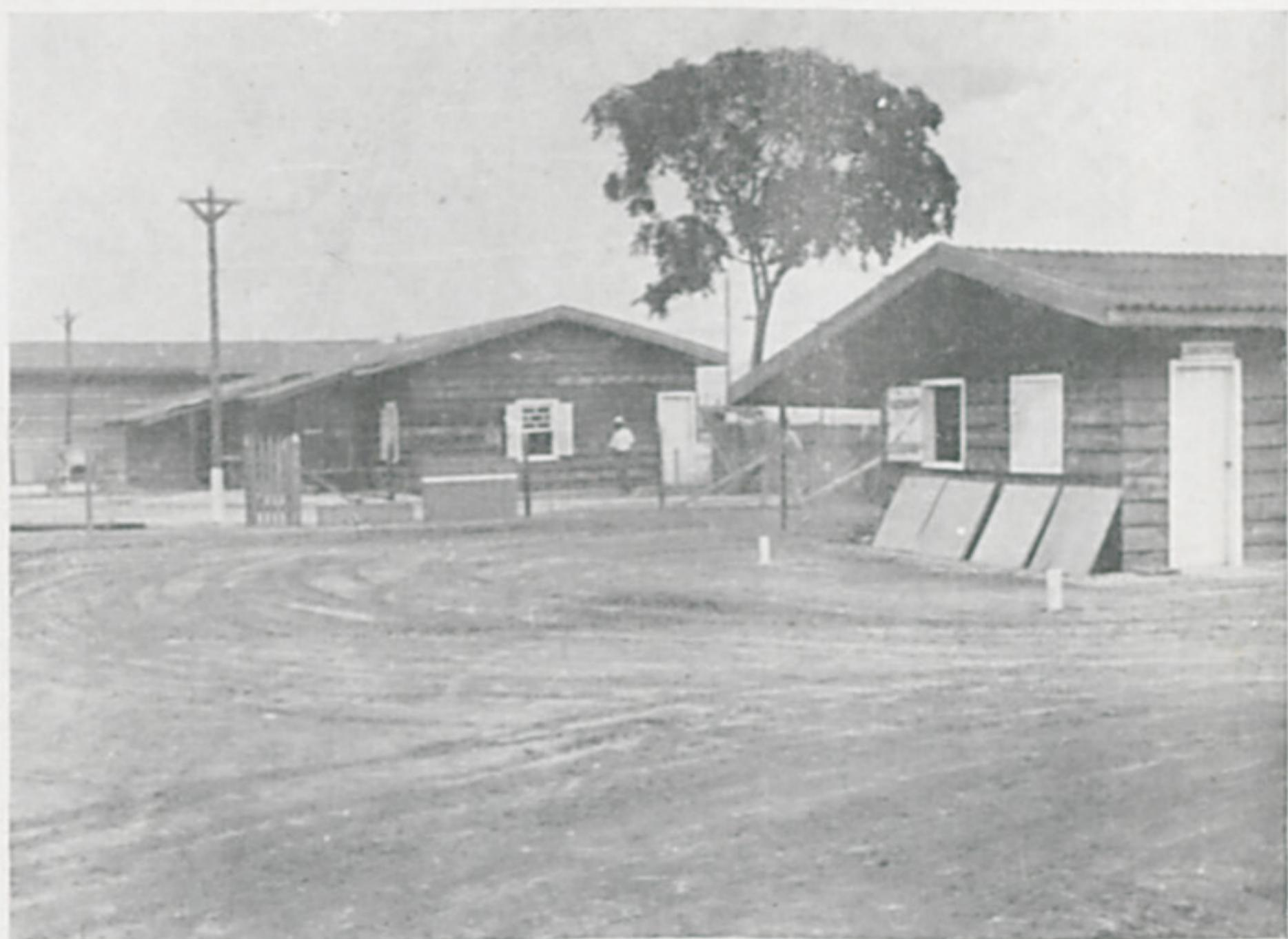
Foto: 4: Os bungalows, que serviam de escritórios, de almoxarifado e de oficinas, construídos de madeira, com telhados de brasilita, foram cuidadosamente e repetidas vezes desinfectados com os inseticidas.
